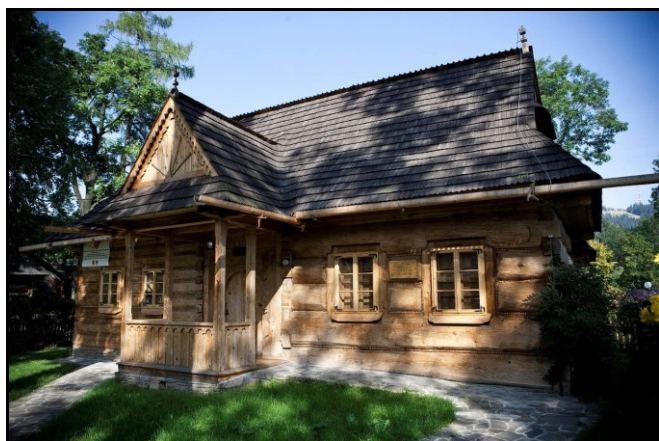
Chałupa Gąsieniców Sobczaków (po remoncie konserwatorskim - 2009 r.)
